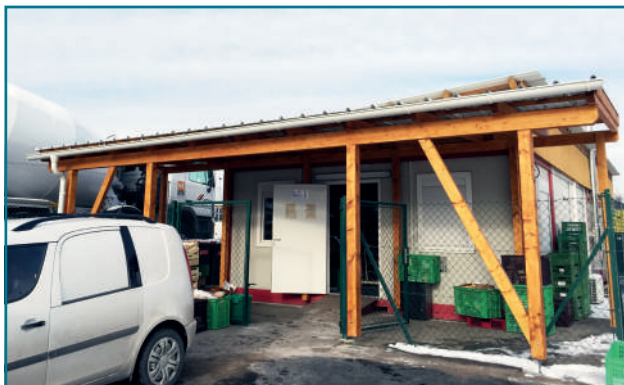
Ein neues Dach für den SOMA Klosterneuburg
